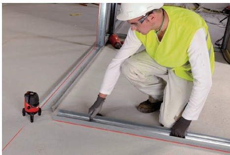
間仕切りランナーの芯出し、矩出し
