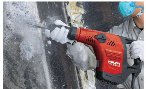
開口、貫通工事に
